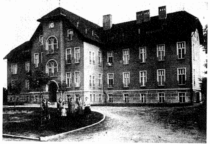
Kreis Krankenhaus Flatow in den 20er Jahren
