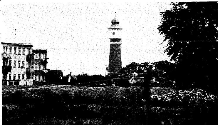
Flatow heute Wasserturm an Krojancker Chaussee. 1910 erbaut. Eingesandt von Johannes Schley.
