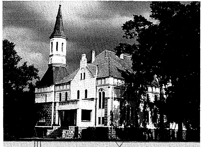
Schloß Dobrin nach der Restaurierung im Sommer 1989
