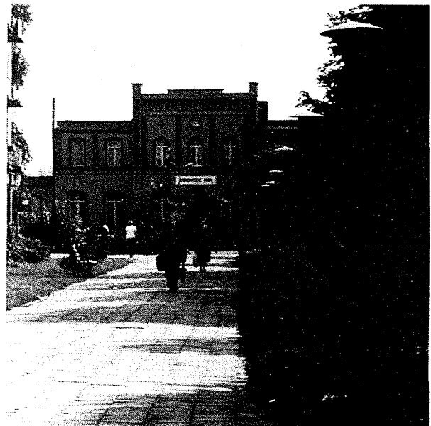
Krojanke heute — Blick auf das Bahnhofsgebäude
