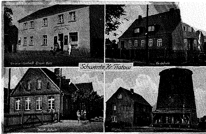
Schwente einst — Ansichtskarte (leicht beschädigt)
