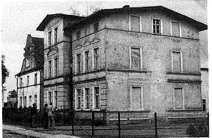
Hammerstein heute - Schießplatzstraße
