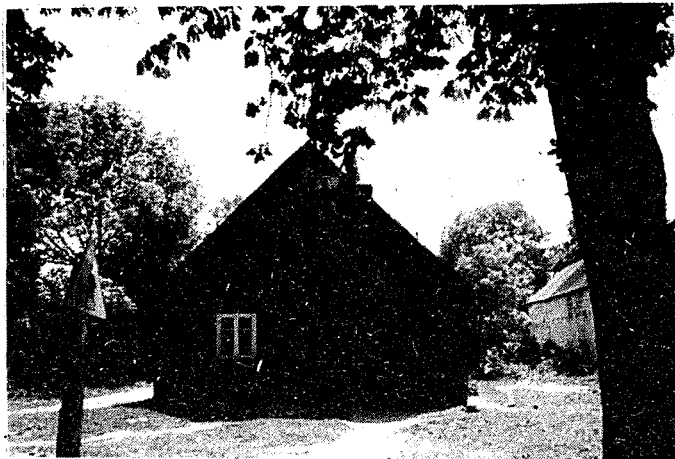
KÖLPIN heute. Das alte Westpreußenhaus, renoviert u. ohne Zaun
