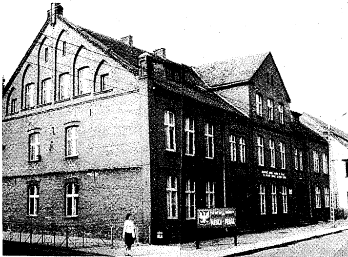
KROJANKE heute Die Similtanschule, dahinter Möbelfabrik Julich
