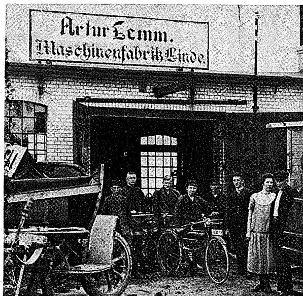
Eine Erinnerung an die unvergessene Heimat Linde bringt das hier gezeigte Foto der „Reparatur-Werkstätte für Autos und Motorräder“ von Arthur Lemm. Nachdem Herr Lemm für einige Jahre eine kleine Werkstatt gepachtet hatte, kaufte er einen zwei Morgen großen Bauplatz, der neben dem Gebäude der Kreisparkassenfiliale gelegen war. Hier errichtete er eine Reparaturwerkstatt. Er beschäftigte mehrere Gesellen und Lehrlinge und gliederte dem Betrieb eine Landmaschinenhandlung an. Aus dieser Zeit stammt das Foto, welches wir unserem Landsmann Oskar Winter in Bad Salzdetfurth verdanken. Er hat dort einen VW-Dienst. Nachfolger von Arthur Lemm wurde Schlossermeister Kurt Lange, der nach der Vertreibung in Kiel eine Tankstelle übernahm. (ahm)
