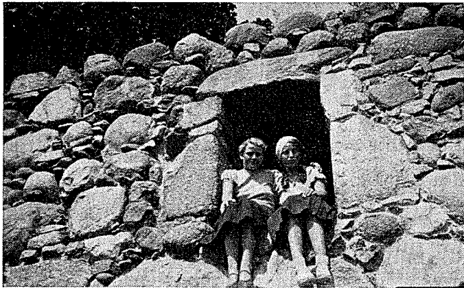
Zwei „Mauerschwalben“ an einem „Fenster“ der etwa vier Meter starken Umfassungsmauer der Ordensburg Schlochau. Es sind Schülerinnen aus Schneidemühl.
