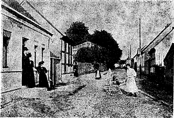
Flatow: In der Brunnenstraße
